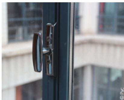
La béquille en aluminium chromé de Beugnot et la crémone ont dû être modifiés et adaptés par l'entreprise de métallerie.
