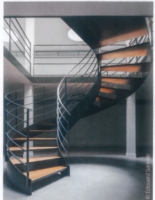
Les marches en bois ont été posées dans l'encadrement avec précision. Elles tiennent sans la moindre vis.
